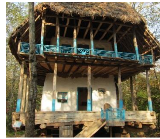
تصویر ۹: خانه روستایی در جلگه شرقی رودنه لاهیجان نرده های با تزئین ترکیبی (هنج: نگارندگان، ۱۳۹۶).
