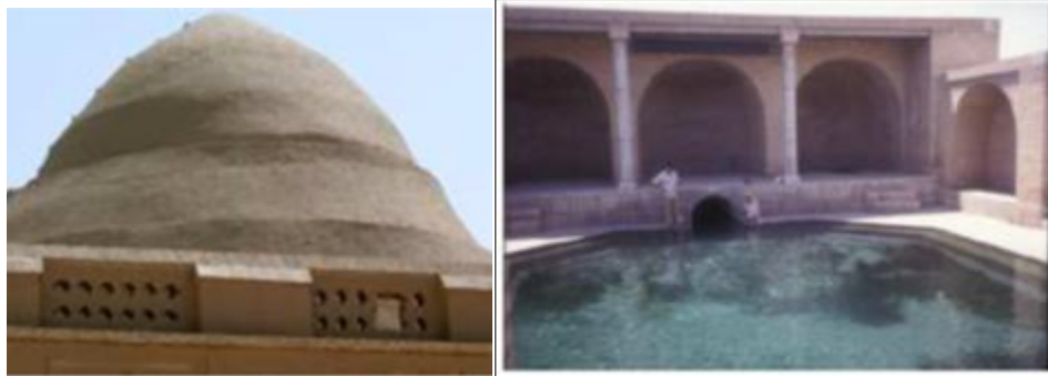
شکل ۷. مظهر (ظهور آب زیرزمینی به سطح استخر). شکل ۸. آب انبار (انبار سرپوشیده آب)
