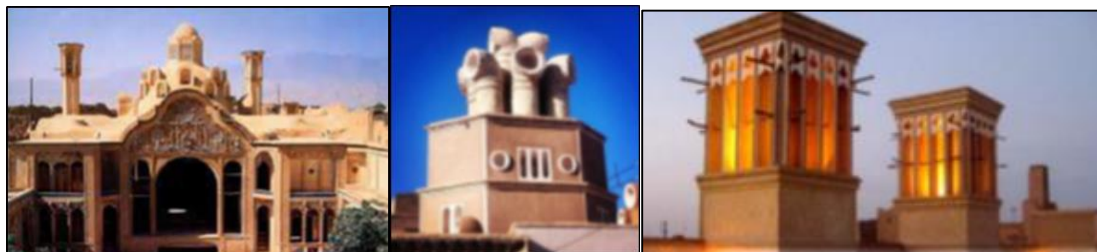
شکل ۱۴. یزد، بادگیر چهار جهته معمول. شکل ۱۵. بادگیر لوله ای شکل کاشان. شکل ۱۶. بادگیر ۶ جهته، کاشان.
