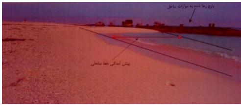
شکل ۱۱. (سمت راست)، نحوه رسوب گذاری در ساحل جنوبی اسکله هتل سیمرخ (منبع: مهندسین مشاور سازه پرداز، ۱۳۸۶) شکل ۱۲. (سمت چپ)، پیش آمدگی ساحل در پشت بارج‌ها شده به موازات ساحل در شمال شرقی مسجد امیرالمومنین (منبع: مهندسین مشاور سازه پرداز، ۱۳۸۶).
