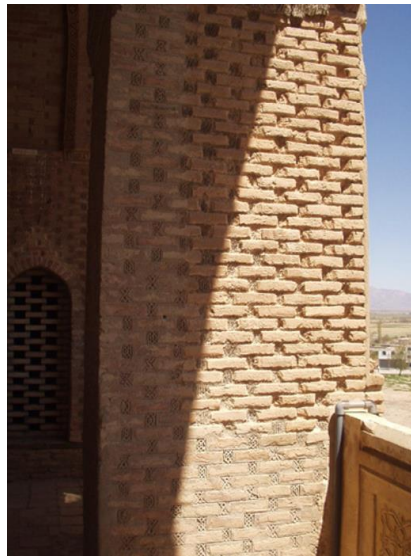
تصویر ۳: نمونه آسیب دیدگی در دیواره جانبی ستون‌ها در بنای سلطانیه. مأخذ: (نگارندگان، ۱۳۹۸)
